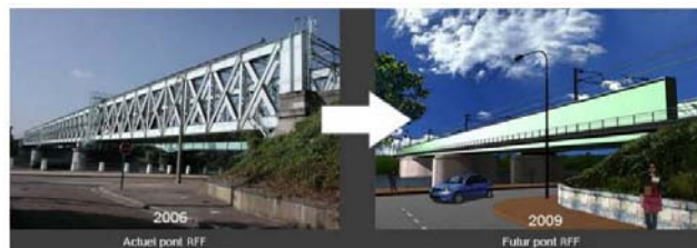
Exemple de changement de pont métallique à Oisssel
