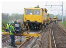
Rails longs soudés sur traverses béton
